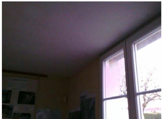
**Vestiaire du chantier d'insertion PASS Sud Charente en hiver (local chauffé). Pertes au niveau de la fenêtre, des montants de rail et du plafond (violet : zones froides et jaune : zones chaudes).**
