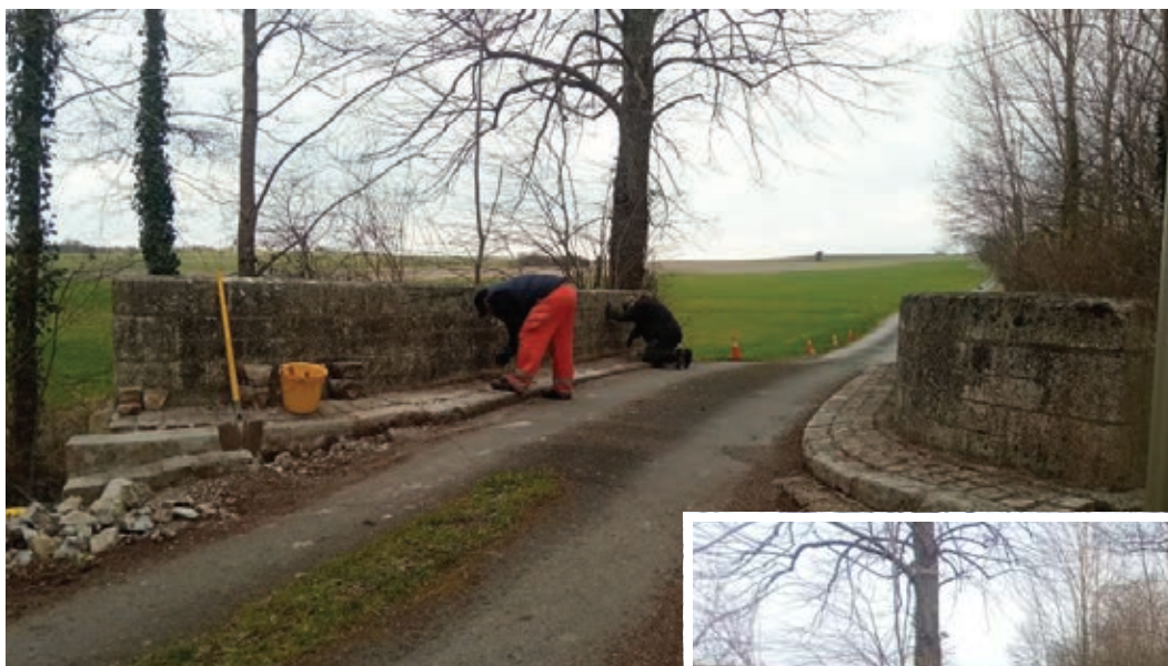
Pont Tamisé, pendant les travaux
