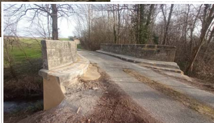
Pont Tamisé, après les travaux
