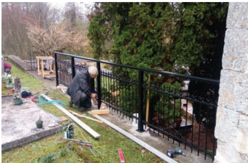
Réfection des barrières du cimetière de Rioux-Martin
