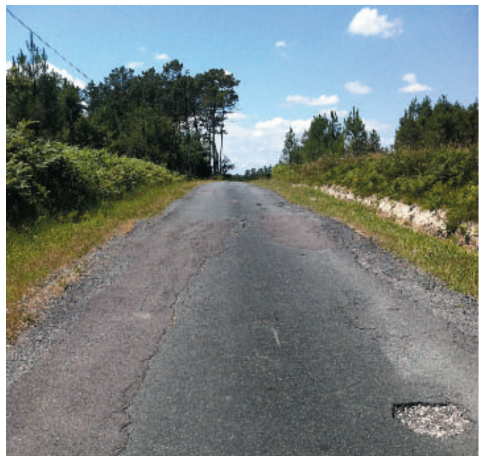
Travaux sur la voie communale n° 4 de Rioux-Martin à Mélac. Réalisation de purges afin de stabiliser la chaussée très dégradée.
