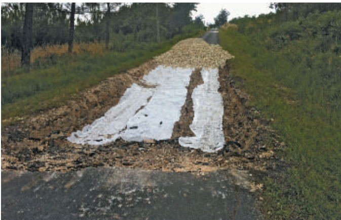
Travaux sur la voie communale n° 4 de Rioux-Martin à Mélac. Réalisation de purges afin de stabiliser la chaussée très dégradée.
