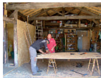
Aménagement de la chaufferie.
