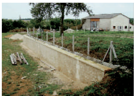
Le mur de soutènement du cimetière.
