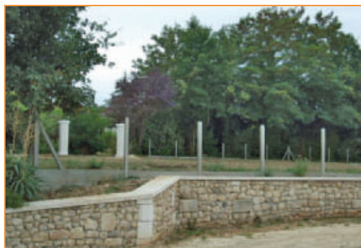
Le mur de soutènement et la clôture du cimetière
