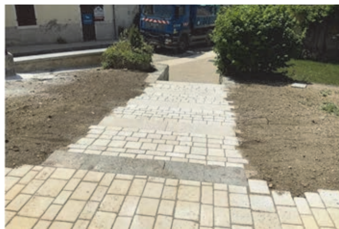
Escalier en « pas d'âne »
