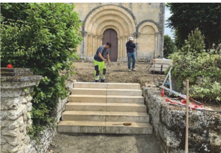
Réfection de l'escalier
