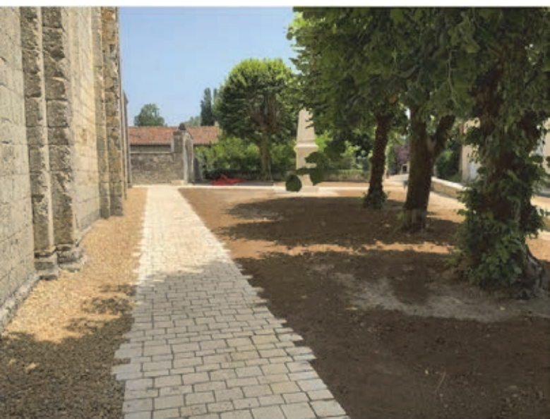
Allée pour l'accès aux personnes à mobilité réduite
