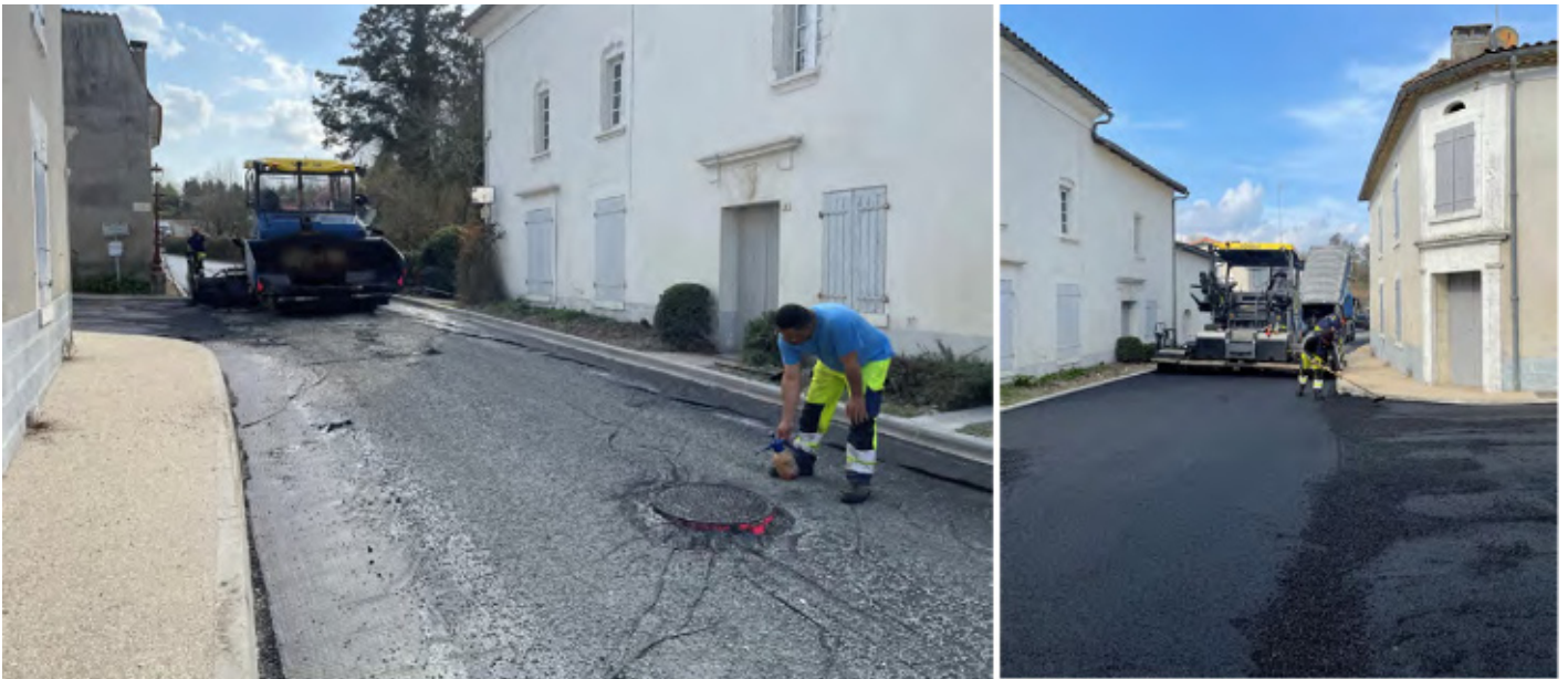
réalisation des enrobés sur la RD n° 20, rue de l'Argentonne.
