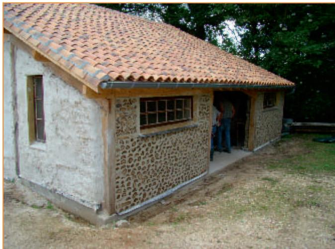
L'atelier communal, en face de la mairie, a fait l'objet d'une rénovation complète de ses murs : les planches de bois ont été remplacées par des murs en bois cordé (bûchettes de châtaignier liées à l'aide d'un mortier de chaux, sciure et bois) et par des murs en paille (bottes de paille empilées et recouvertes d'un enduit à la chaux).
